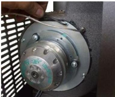
Fig. 33 - Fume fan cleaning: phase 1
